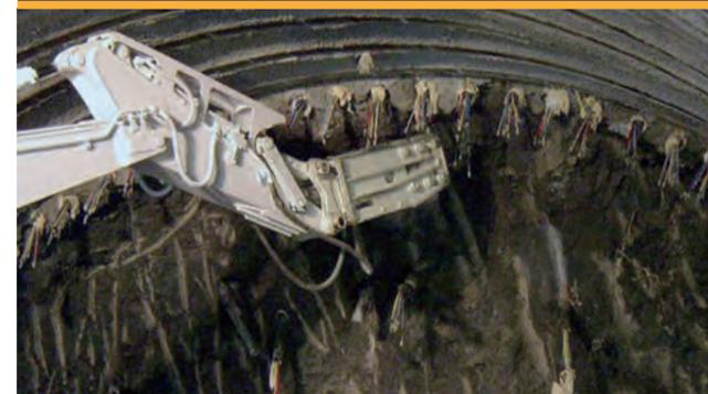
トンネル現場でのブレーカ作業は、上向きや横向きでの作業が多く、油圧ブレーカにとって極めて苛酷な作業環境です。トンネル仕様油圧ブレーカは、油圧ブレーカ本体内部に水やダストなどが混入するのを防ぐだけでなく、油圧ショベルの作動油に汚染が起きないように未然に防止します。
