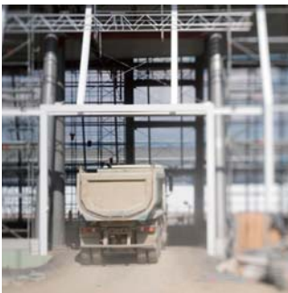
建設作業現場
