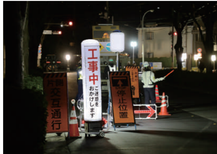
🌙 道路舗装現場
