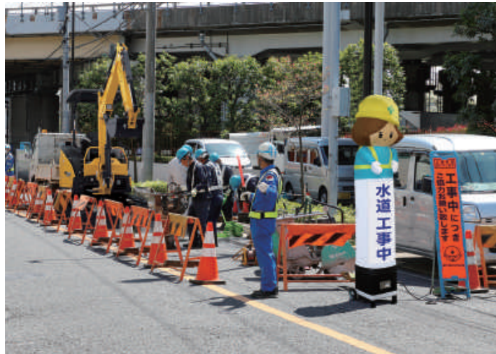
☀️ 水道管補修現場
